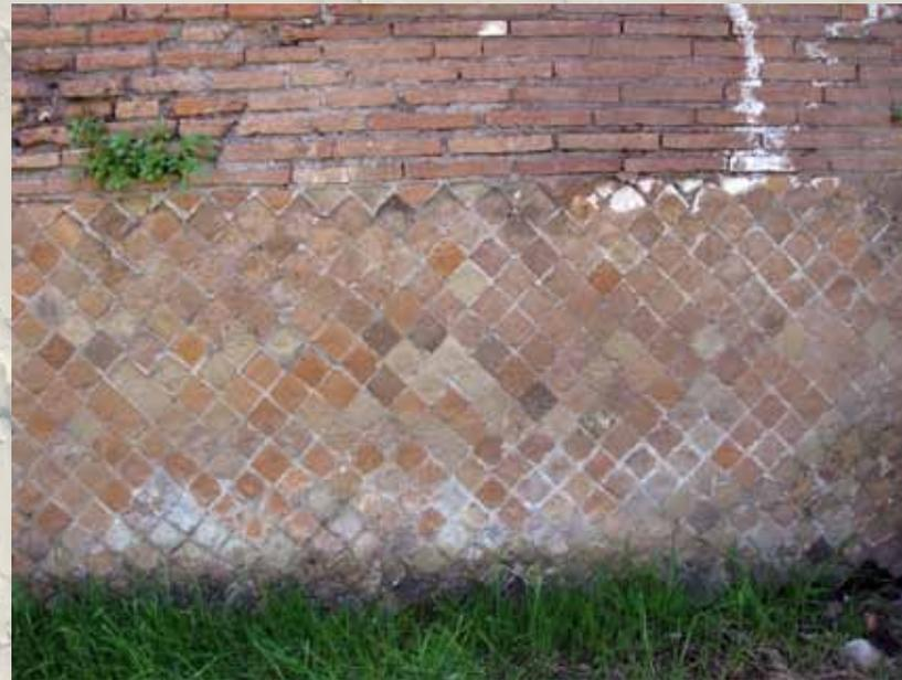
Foto 8 - Muro ricostruito in opus reticulatum
