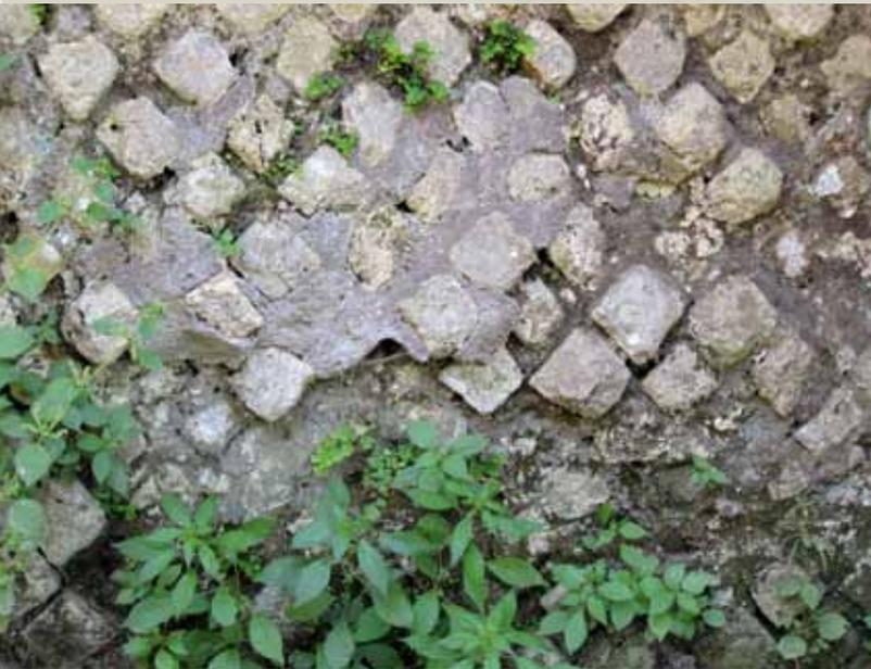
Foto 7 - Muro originale in opus reticulatum
